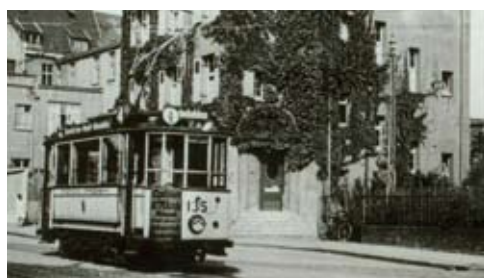
Die Linie nach Rheindahlen passiert 1931 das Nebengebäude des Finanzamtes Rheydt.
